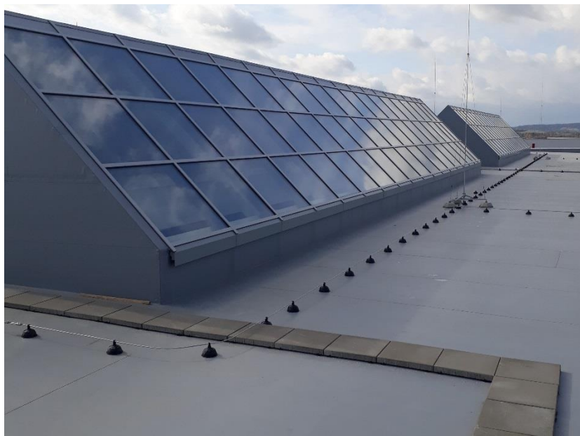
Obr. 1 Pohled na dokončenou plochou střechu [7]
