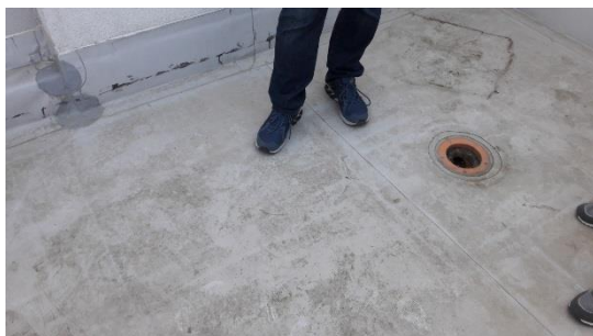
Obr. 7 Vodný vankúš medzi pôvodnou a novou povlakovou krytinou na terase
