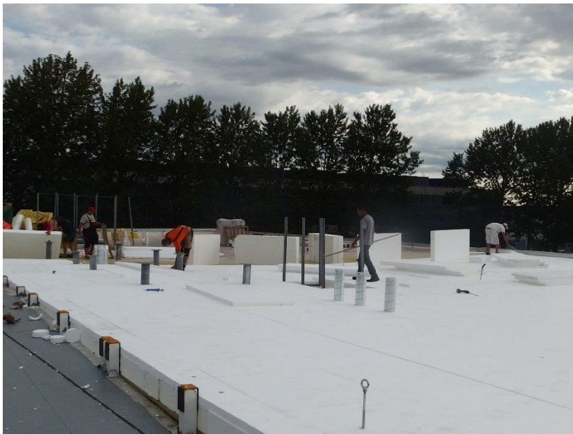
Obr. 2 Pokládka tepelné izolace [7]
