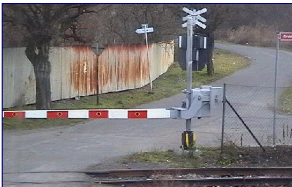
Obr. 1 Přejezd zabezpečený světelnou signalizací, doplněný břevny závor
