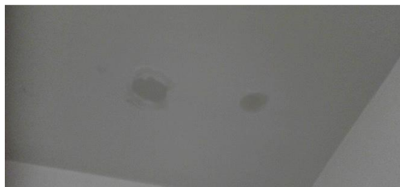
Obr. 1 Zatekanie na strope miestnosti na 3. NP
