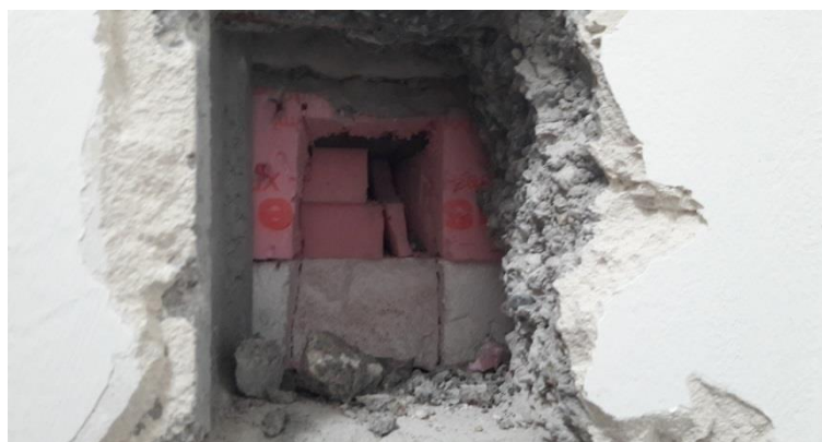
Obr. 3 Pohľad do vykonanej sondy s viditeľným EPS polystyrénom
