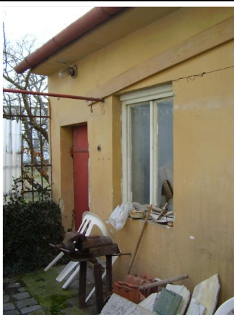
Obr. 3 Vstup do technické místnosti
