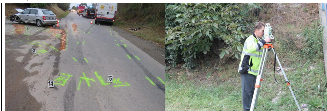
Obr. 7 a, b Pohled na místo střetu a jeho zaměření totální stanicí
