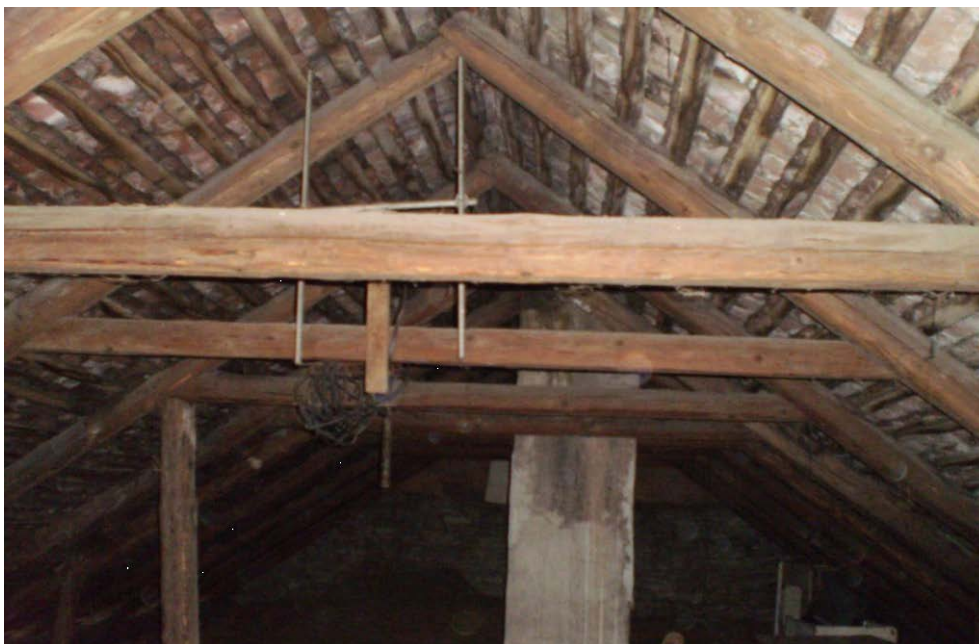
Obr. 3 Celkový pohled na krov [3]
