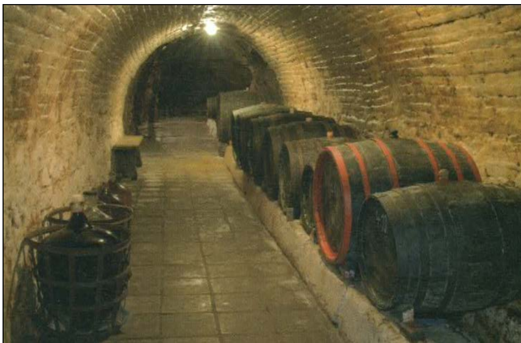
Obr. 3 Kvelbený vinný sklep ve vinařské obci Bzenec [12]
