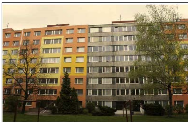
Obr. 5 Panelový dům typu T08B [9, 8]
