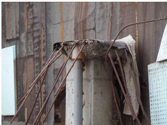
Obr. 1 Typické porušení desky v místě styku se sloupem
