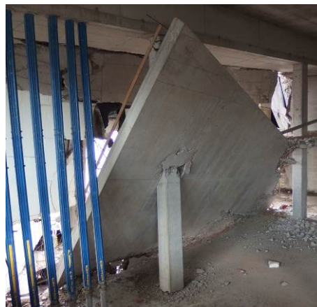
Obr. 2 Havárie desky způsobená protlačením
