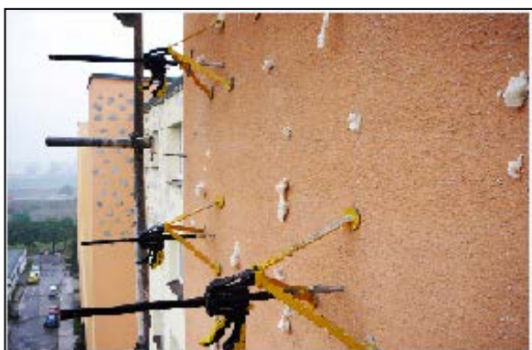
Obr. 3 Sanace nestabilního zateplení pomocí injektovaného kotvení [2, 3]
